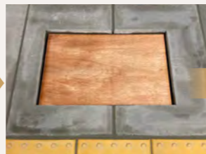
蓋タイル用の合板設置
