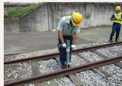
バッテリー式犬クギ抜き機 犬クギ抜き機の煩わしいコードを無くしました
