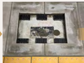
高さ調整カンバーの設置
