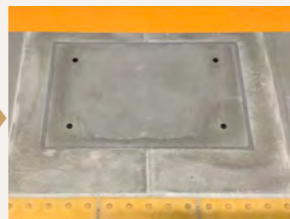
蓋タイトルの取付完了
