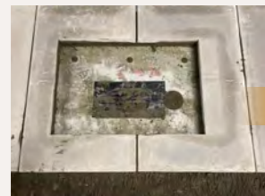
切欠きホーム先端タイトルの設置
