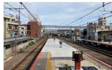
PC床板敷設完了
