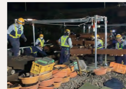
橋マクラギ山越器 橋マクラギ交換の重労働を軽減
