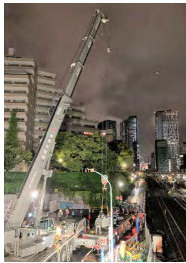
既設階段撤去状況
