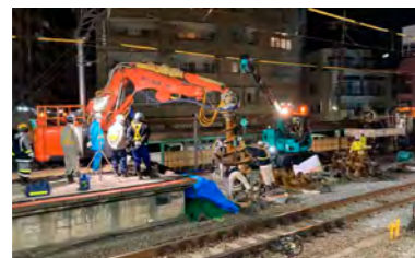
基礎施工状況
