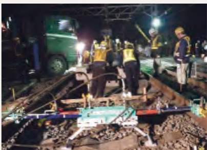
レールストレッチャー レールを広げて接続軌道(踏切)の施工が可能
