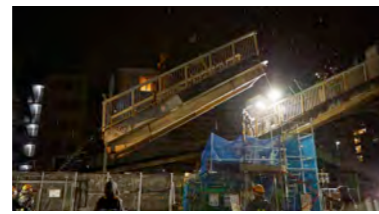
既設階段撤去状況
